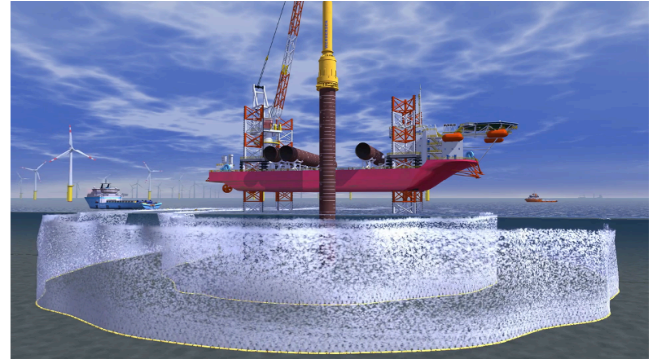
Fig.7. Illustration du rideau de bulles autour d'un atelier de battage (source : Gaia terre-bleue, Impact mer, DHI et Bird&Bird)
