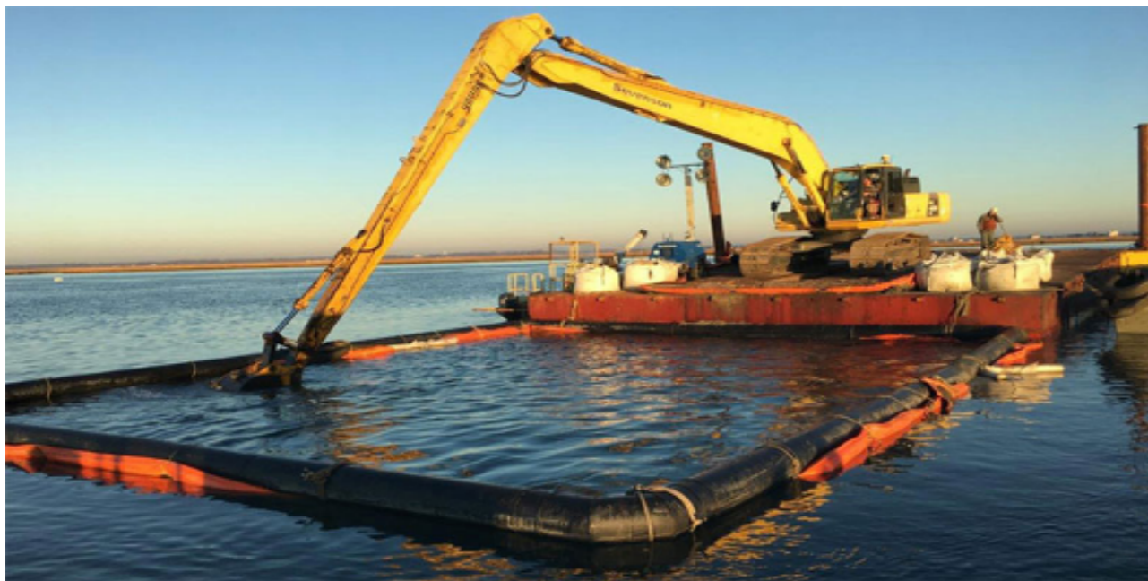
Fig.10. Rideau anti-matières en suspension autour de l'atelier de dragage (Source : Gaia terre-bleue, Impact mer, DHI et Bird&Bird)
