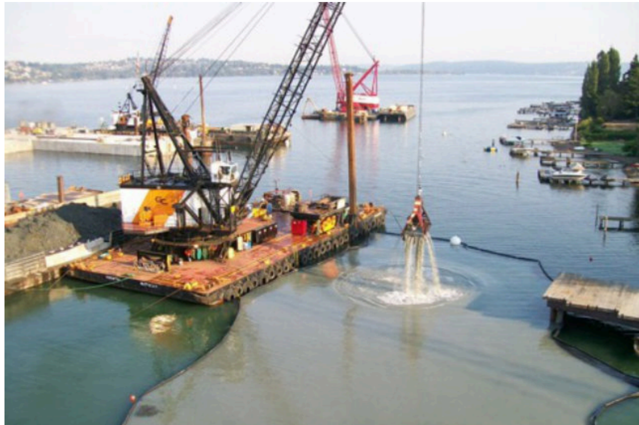
Figure 7 : Illustrations de la mise en place d'un rideau anti-MES au niveau d'un atelier de dragage (source Web)
