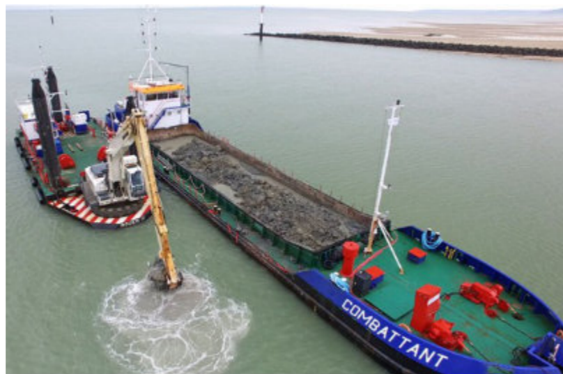
Figure 5 : Exemple d'un dragage mécanique (source Océlian - VCMF)
